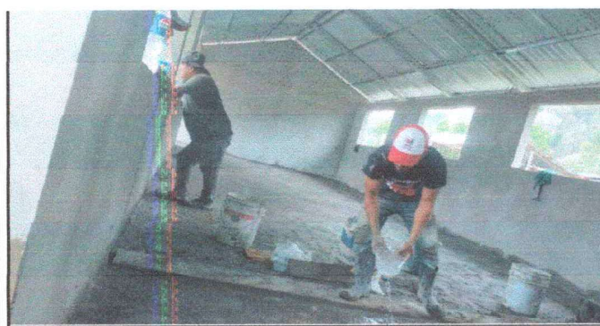
Foto 5: SEGUIMIENTO DE LA ELABORACION DE CONSTRUCCIÓN DE PISO PULIDO
