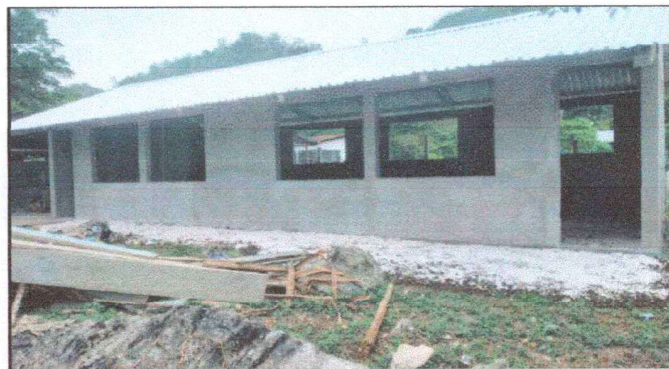
Foto 4: RESPECTIVO FACHADA DENTRO Y FUERA DEL AULA CON SU REPELLO
