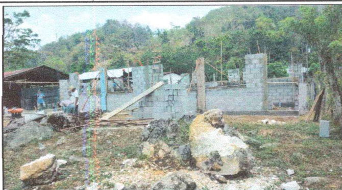
Foto 1: LEVANTAMIENTO DE LA PRIMERA FASE DEL AULA
