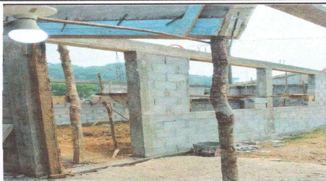
Foto 2: SEGUIMIENTO Y AVANCE DEL NIVEL DE LINTEL
