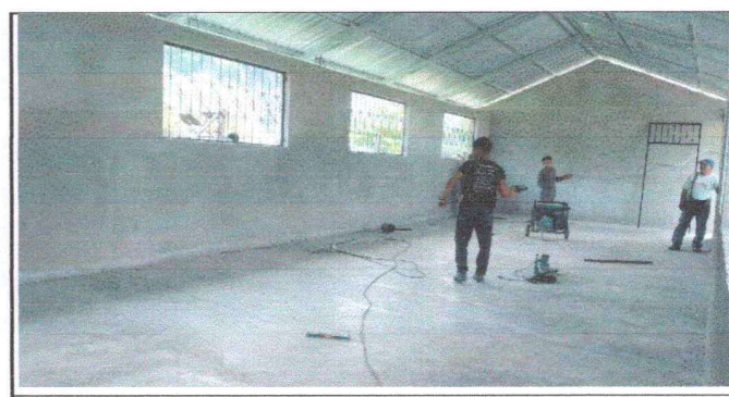
Foto 6: EN ESTA FOTOGRAFÍA EVIDENCIA SOBRE EL AVANCE DEL REMOZAMIENTO
